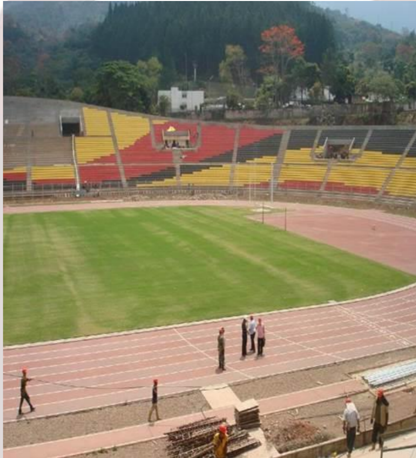
Polideportivo de Pueblo Nuevo (Táchira)
